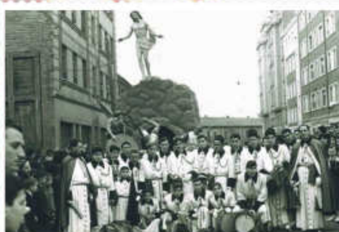
1959. Llegada de la procesión del Encuentro a la Iglesia de San Juan y San Pedro de Renueva.
